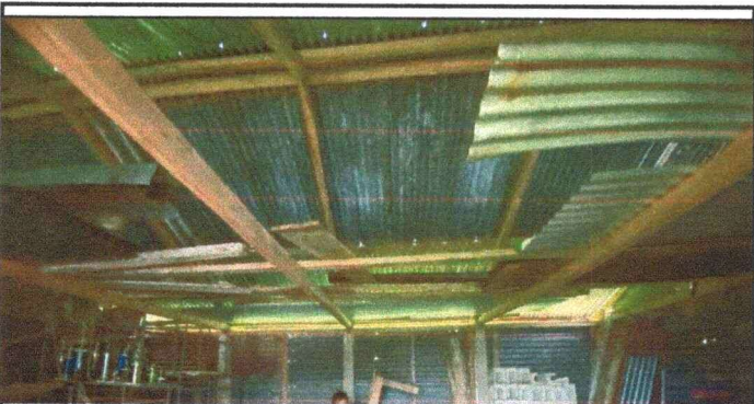
Foto 5: Sustitución de techo y estructura de madera por metal
